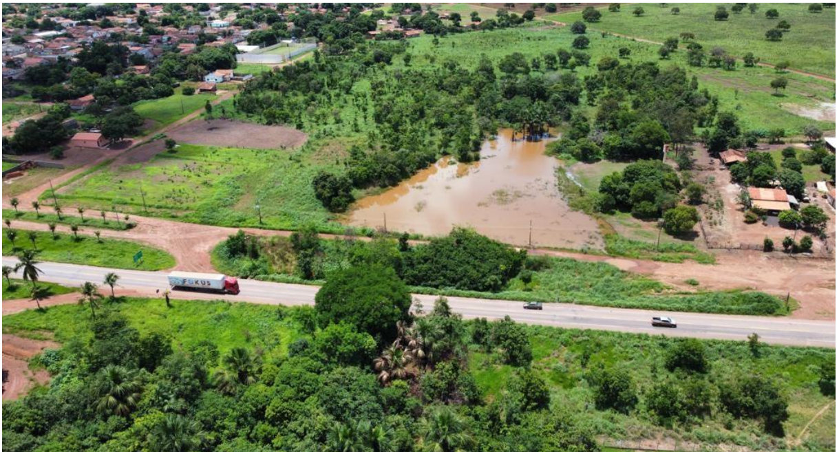
Figura 2 – Vista aérea da represa construída junto a nascente do Ribeirão São Josezinho. Fonte: Imagem dos Autores (2021).
