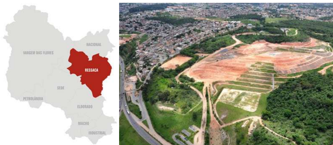
Figura 27 - Reserva Biológica do Aterro Sanitário
