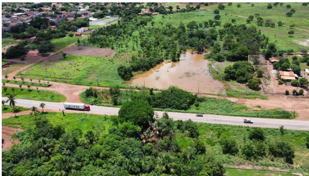
FIGURA 2 – VISTA AÉREA DA REPRESA CONSTRUÍDA JUNTO A NASCENTE DO RIBEIRÃO SÃO JOSEZINHO. FONTE: IMAGEM DOS AUTORES (2021).
