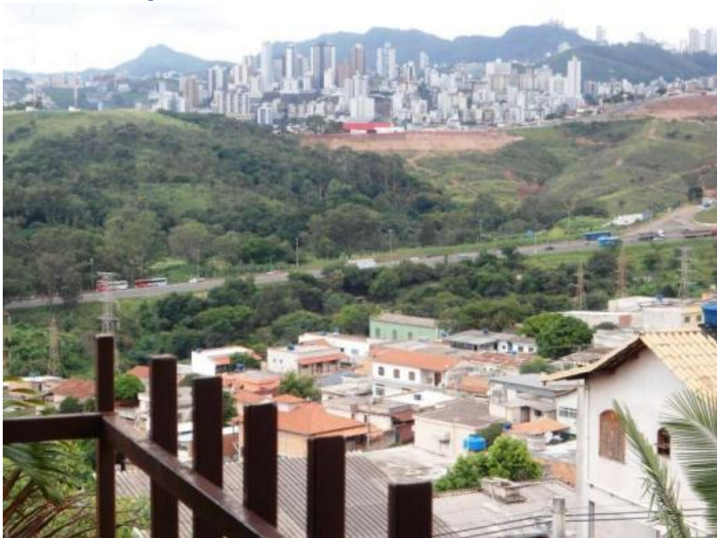
Figura 16 – Vista do Bairro Novo das Indústrias.
