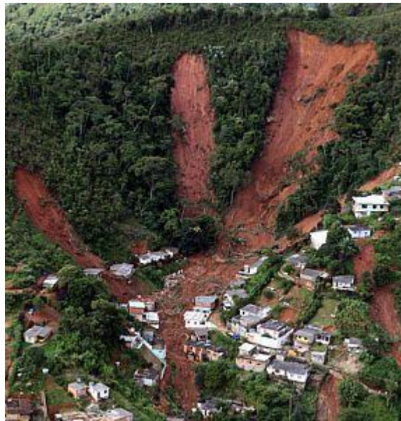
Figura 03 – Imagem do desmoronamento de encosta em área de mata atlântica
