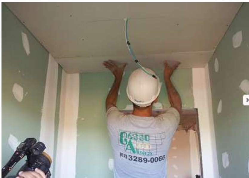
Figura 3 – Imagem da Instalação de Gesso
