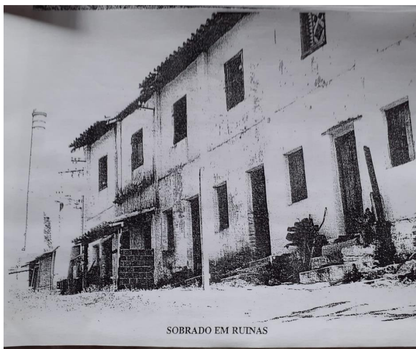
Figura 10 - Ruínas de sobrado em Marzagão
