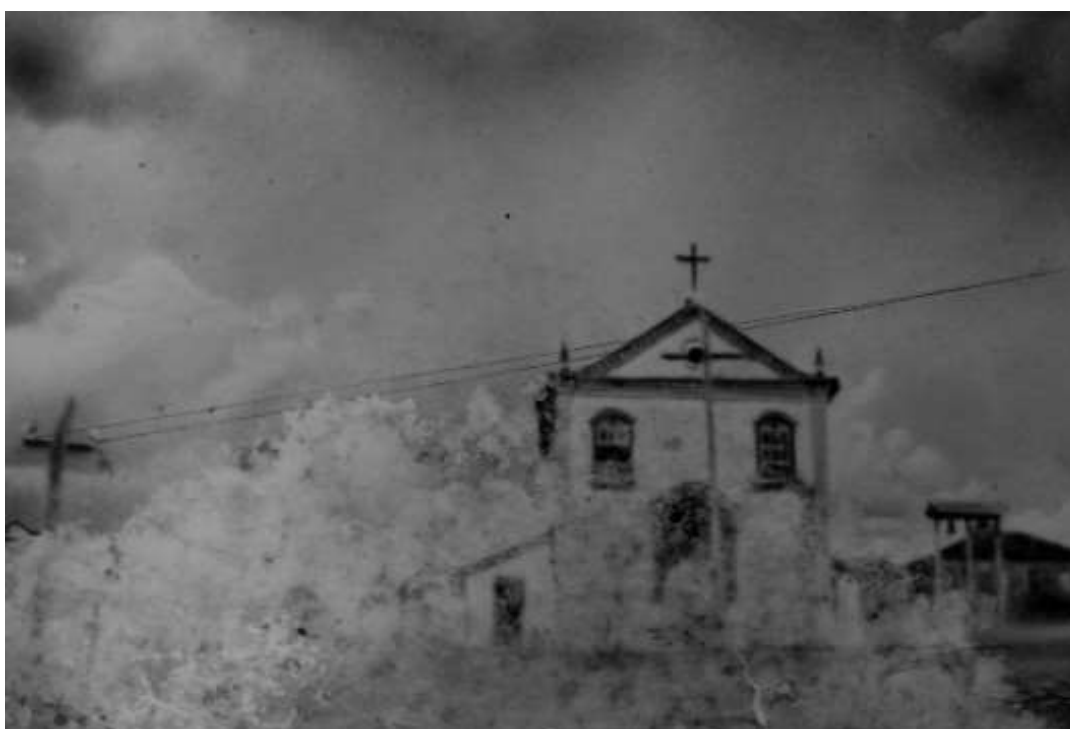
Foto 04 – Foto deteriorada da Capela Velha do Desterro
