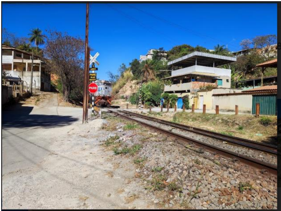
Figura 01 - Casas a serem desapropriadas no leito ferroviário, Bairro Beija Flor
