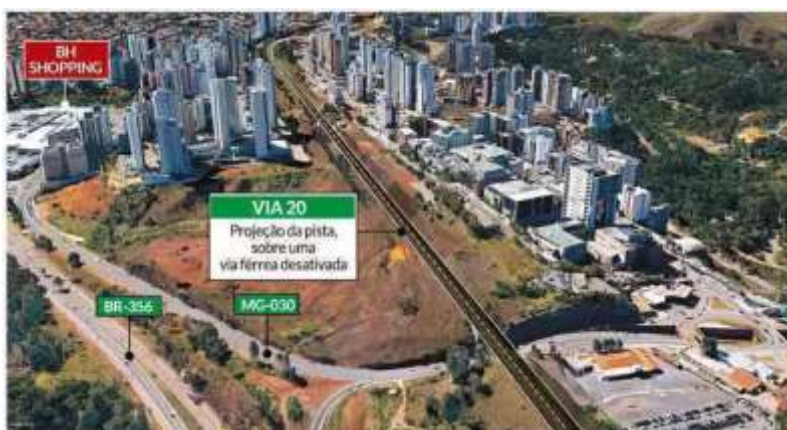
Figura 16 - Local para construção do Terminal Sul, no Belvedere
