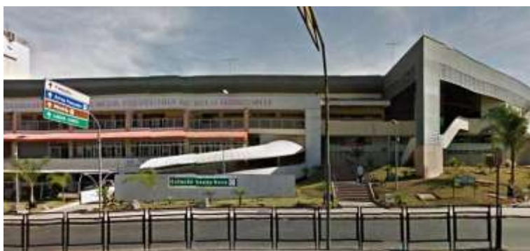
Figura 12 - Terminal Norte, localizado em Venda Nova
