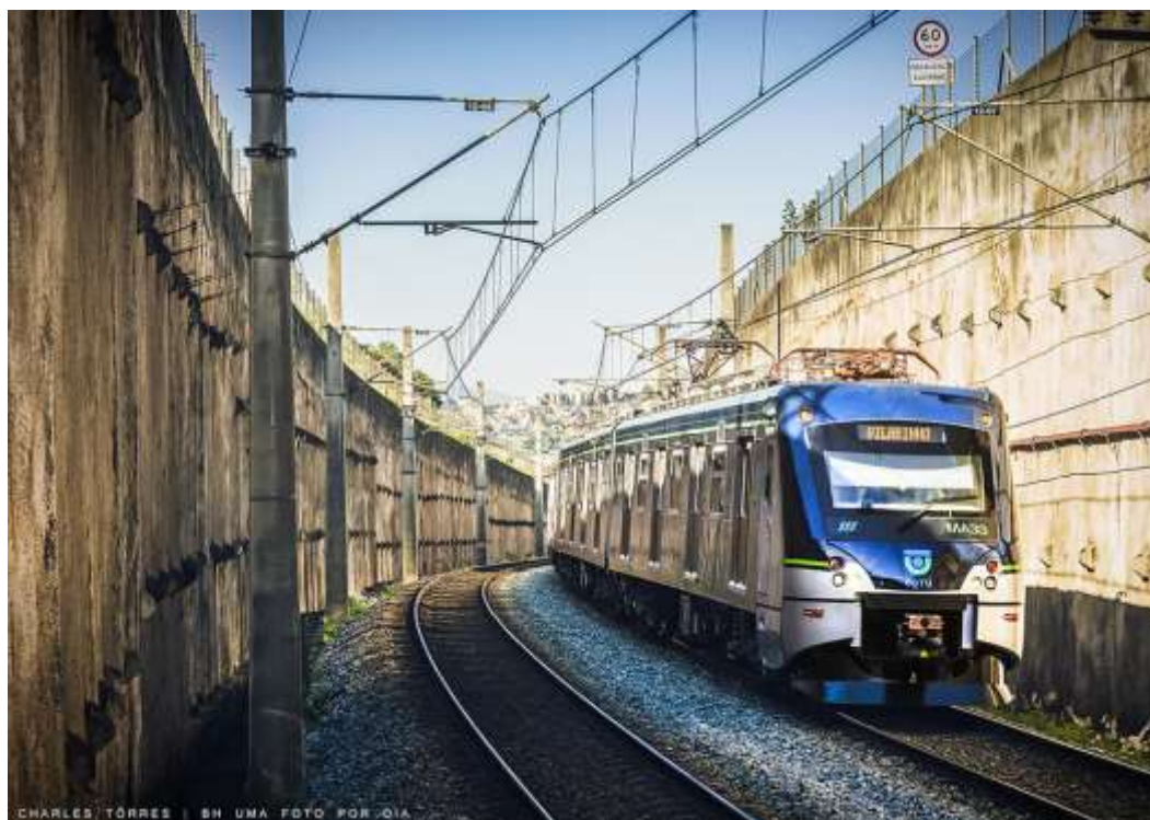
Figura 03 - Estação Metroferroviária de Waldomiro Lobo
