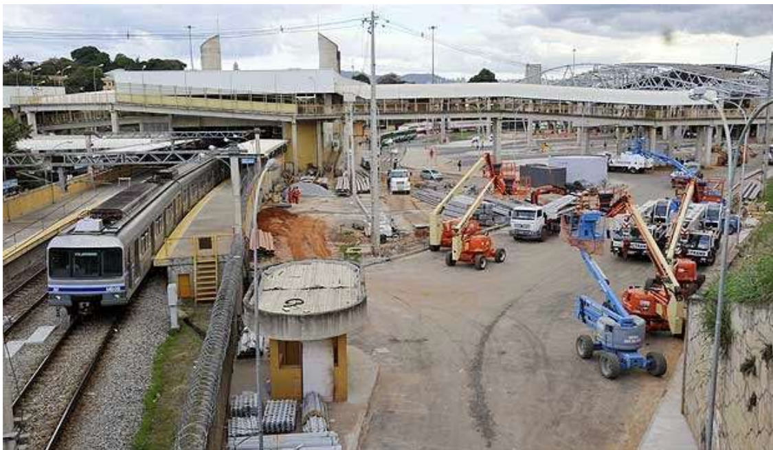
Figura 02 - Estação Metroferroviária de São Gabriel
