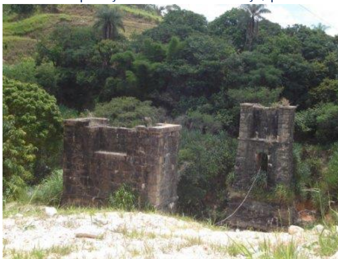
Figura 01 – Ruínas da ponte de transposição do Ribeirão Onça, próxima à estação
