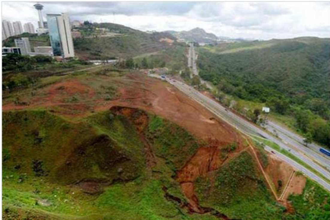
Figura 03 - BR 356, na altura do Cercadinho, numa região elevada da Serra da Água Quente
